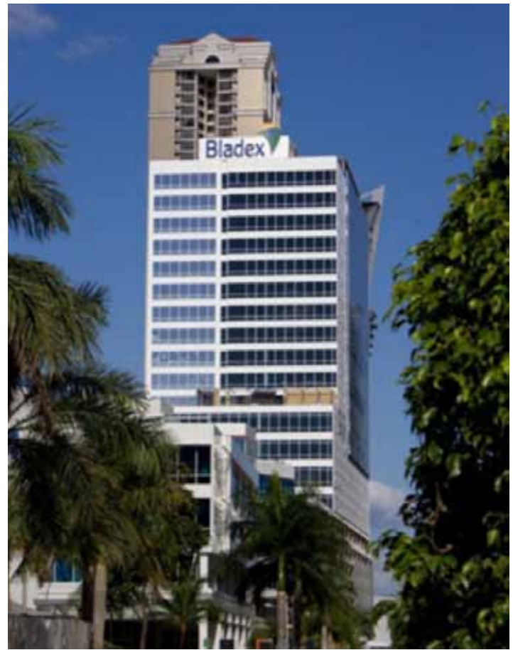
Edificio con Certificación Leed
